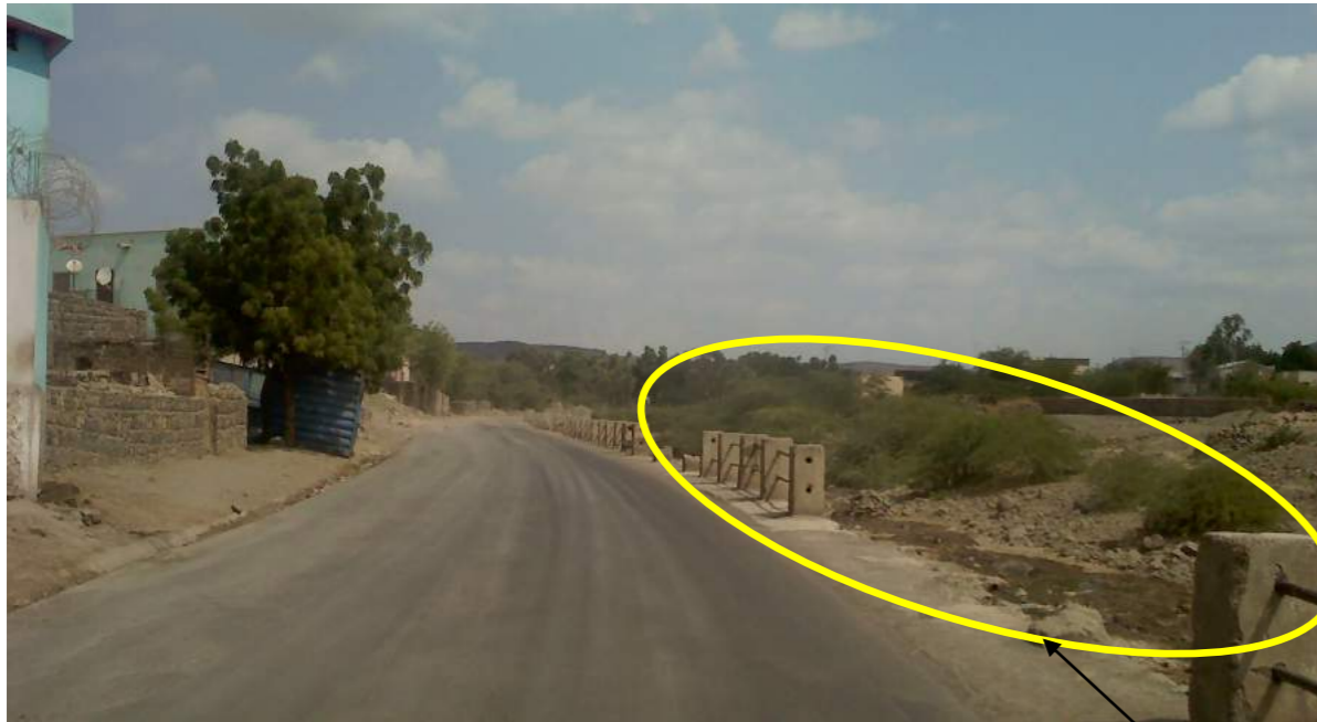
RN1 traversant la ville de Dikhil le long de l'oued Source : photos SCET-TUNISIE, juillet 2013
